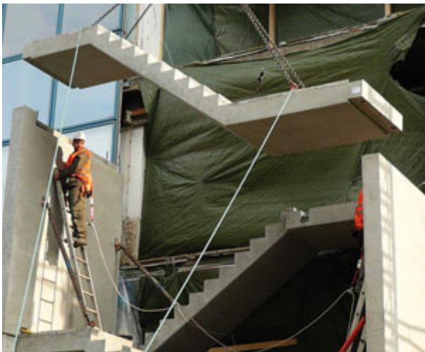
Kuva 7: Lepotasot sisältävän porraselementin asennus
