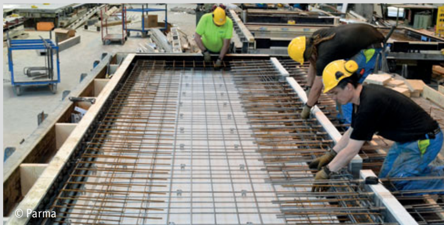
NIROa asennetaan parvekelaattaan Parman Kangasalan tehtaalla.
