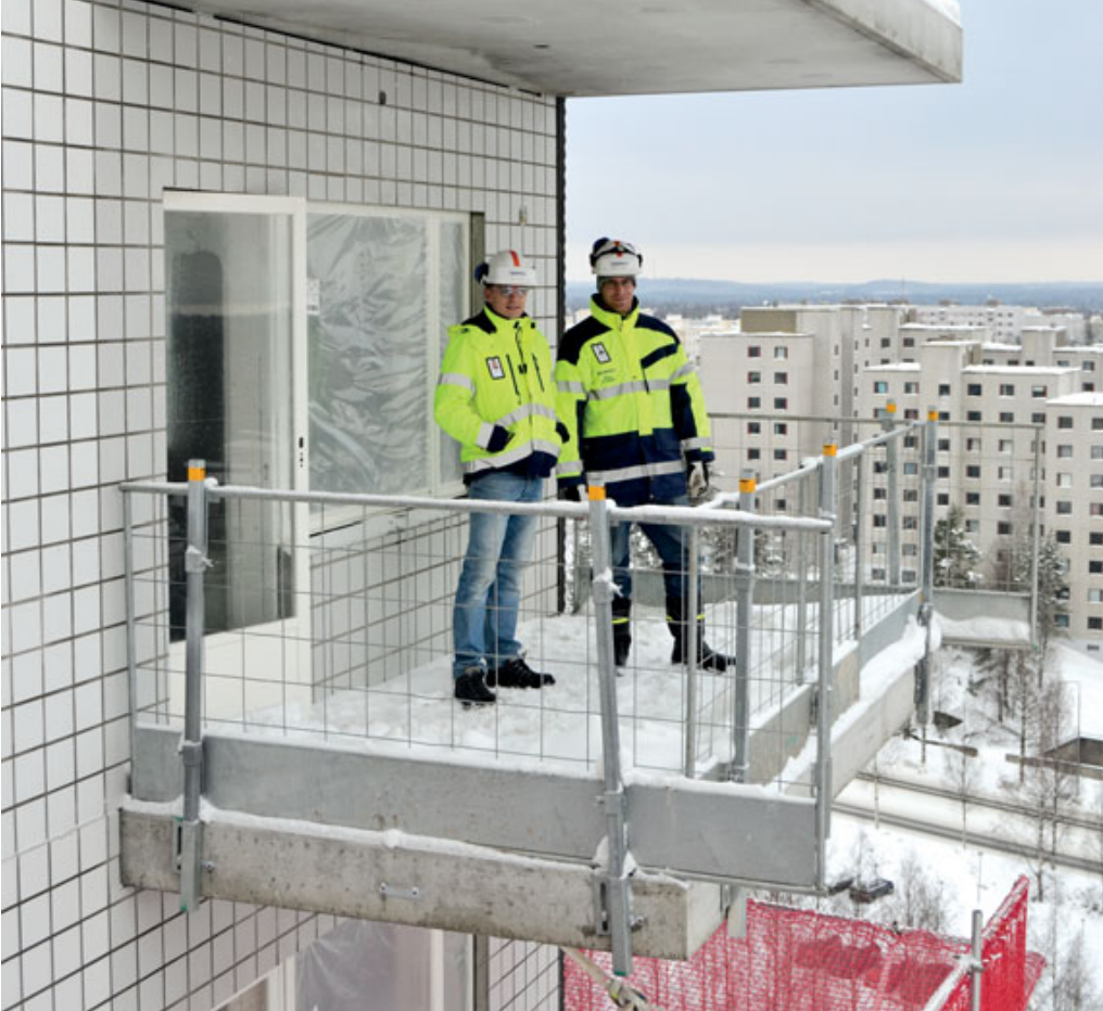
Skanskan Perttu Pitkälä ja Teemu Salminen Matrixin 16 kerroksen parvekkeella.
