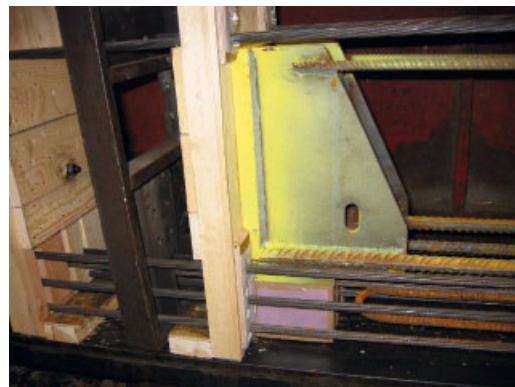
Kuva 12 Esimerkki lisäraudoituksesta ja PC-palkkikengän kiinnityksestä ennen valua
