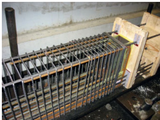
Kuva 12 Esimerkki lisäraudoituksesta ja PC-palkkikengän kiinnityksestä ennen valua
