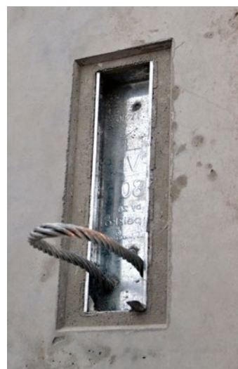
Kuva 10. PVL-vaijerilenkkien asentaminen työmaalla.
