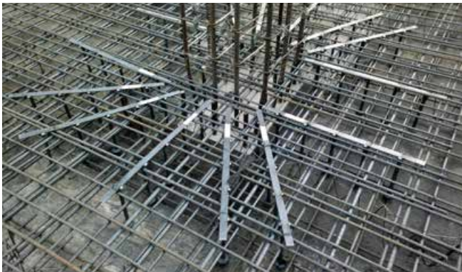
Skanskan Green House toimistorakennus, Budapest, Unkari
