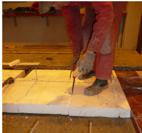
Kuva 21. Kovien eristelevyjen välisten rakojen tiivistäminen.
