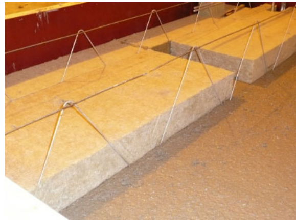
Kuva 21. Kovien eristelevyjen välisten rakojen tiivistäminen.
